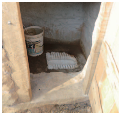
WVから支給された便器とセメントで住民自身が設置したトイレ
