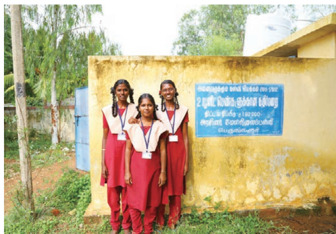
ADPの支援で学校に男女別の水洗トイレができました。屋根の上にあるのが水のタンクです
