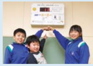
学校内に設置された、発電量を示すパネル
