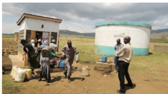
貯水タンク(右)と水の販売所(左)。住民は10-30リットルのプラスチック容器を持参し、容量に応じて料金を払っています
