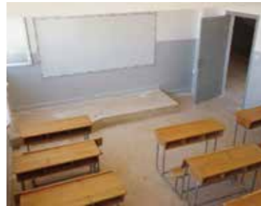
修復後の教室内部
