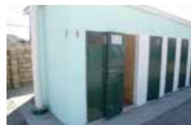
新設されたトイレ
